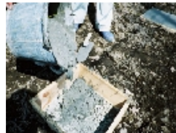
③ コンクリートを流し込む。
