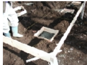
② 枠石を入れて固める。 この時に高さ調整もする。
