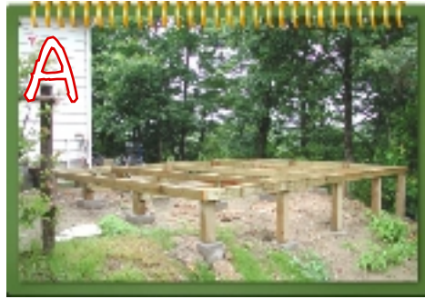
A 素人の方におすすめ 高さの調整は木柱でOK
