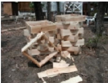
① まず型枠を作る。
