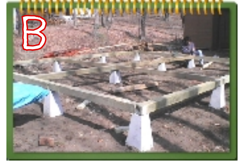
B ちょっと大変！ 高さの調整は コンクリートでする
